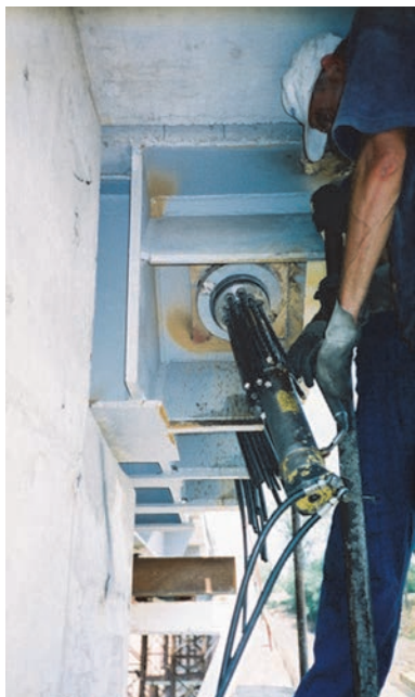
Slika 1. Zatezanje kabela lakom hidrauličnom prešom (eng. monostrand jack )
